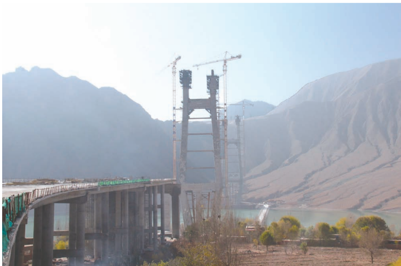
正在实施的哇加滩黄河特大桥为双塔双索面钢混叠合梁斜拉桥,全长1743.5m,主桥长1000米,主跨560米。截止11月15日,33节主墩塔柱已完成26节段;34节段主墩塔柱已完成29节段;4个辅助墩、过渡墩均以完成。计划2015年底塔区主梁安装,桥面吊机安装,2016年底实现主梁合龙,2017年9月前全面完成。该工程建成后将会成为牙同公路上的标志性建筑,同时也是牙同公路建设重点控制性工程。敬请期待鲁迅山下、黄河之上的斜拉桥的完工。 郭广智 摄
