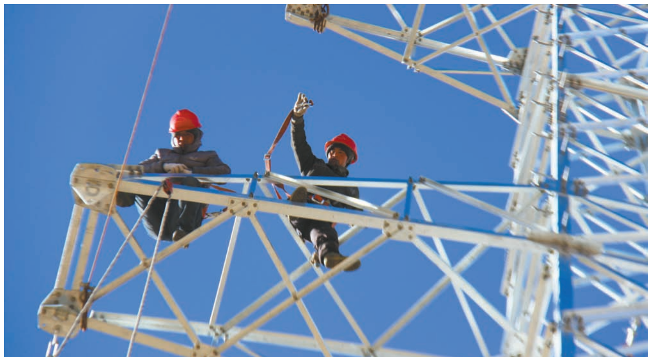
同仁县隆务镇——泽库县夏德日镇Ⅱ回110千伏线路工程总投资9324万元,线路起于同仁县隆务镇110千伏变电站,终于泽库县夏德日镇110千伏变电站,全长约86.6千米,路线经过我州同仁县、泽库县境内,项目于6月28日开工建设,计划于明年5月30日建成投运。该线路的建成投运将有力地保障和极大地提高泽库、河南两县用电畅通和电网质量。
