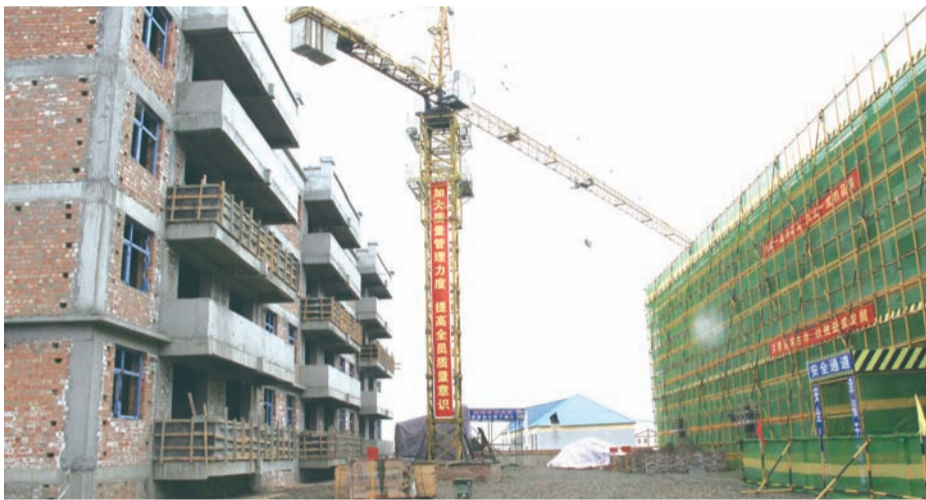
泽库县大力实施棚户区改造项目,今年确定老政府、公安局家属院等22个改造片区,涉及246户、改造面积8.98万平方米。今年计划完成3个片区,预计投资2.8亿元。美丽、幸福、和谐小区相继开工建设。图为正在建设中的幸福小区。
