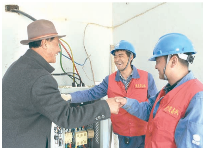
供电员工指导村民安全用电。沈晓琛 摄
