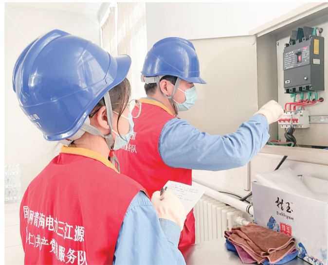
线路安全检查 全丹旭 摄
